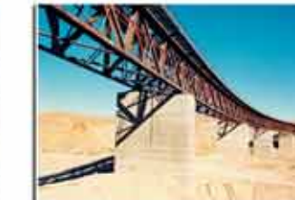
● قطعه ۱۱ راه آهن باقق - بندرعباس اولین پروژه راه آهن پس از پیروزی انقلاب اسلامی طول پروژه ۵۰ کیلومتر / شامل ۲ پل خرابای فلزی سال بهره برداری ۱۳۷۳
