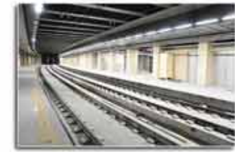
● تونل ها و ۱۲ ایستگاه از خط یک و توسعه خط یک و ۳ ایستگاه از خط دو قطار شهری مشهد
