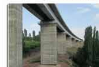
● راه آهن میانه - بستان آباد - تبریز طول پروژه ۴۲ کیلومتر (قطعات ۲، ۳ و ۴) شامل ۸ پل بزرگ دره ای به روش پیشرانی عرشه و ۳ تونل و یک ایستگاه / جاری
