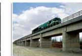
● راه آهن مراغه - ارومیه طول پروژه ۶۳ کیلومتر (قطعات ۱ الی ۳) شامل ۲۴ پل بزرگ / جاری
